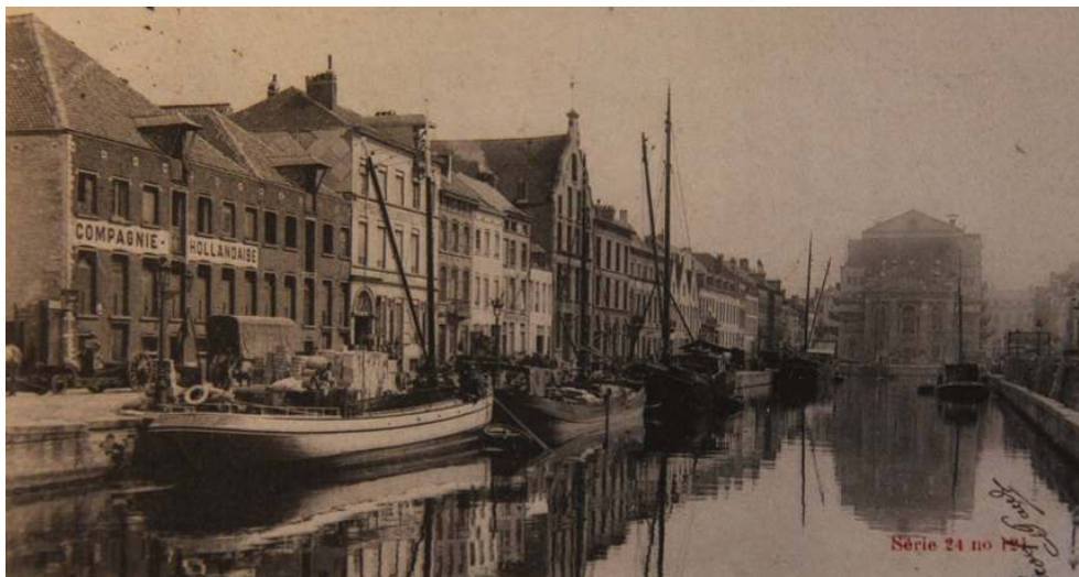
Figure 2. Vue des quais de Bruxelles au XIX e siècle avec, à gauche, l'entrepôt de foin (1841) de l'Ancienne Compagnie Hollandaise. Deux poulies protégées par des chiens-assis et des portes étagées permettaient de hisser le fourrage dans le bâtiment. Quai au Foin 59-60.
