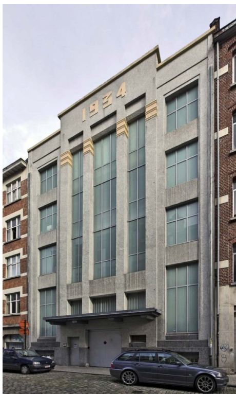
Figure 9. Le cimorné 14 , enduit au ciment décoratif typique de l'entre-deux-guerres, est utilisé pour la façade de l'entrepôt de textile des Établissements I. & M. Blum (1934).
