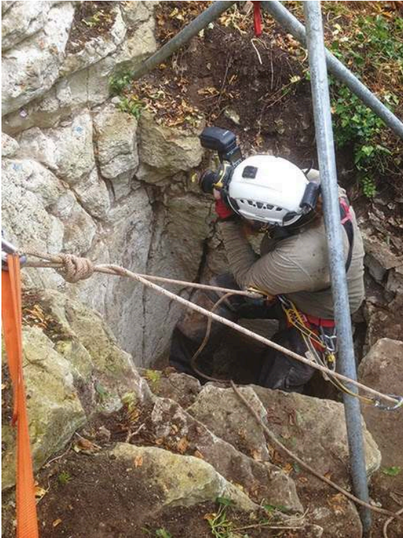
Fig. 1 – Relevé photogrammétrique en rappel dans le puits
