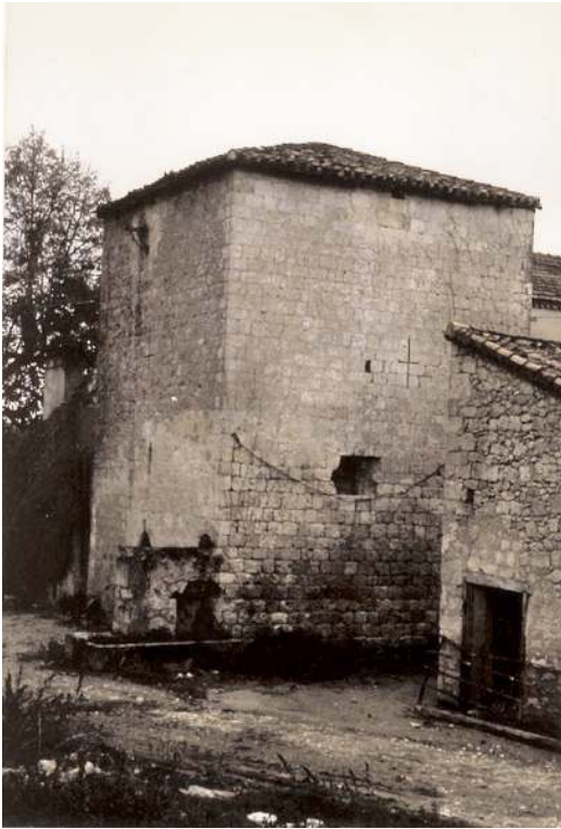
Fig. n°2 : Maison forte de Lasalle
