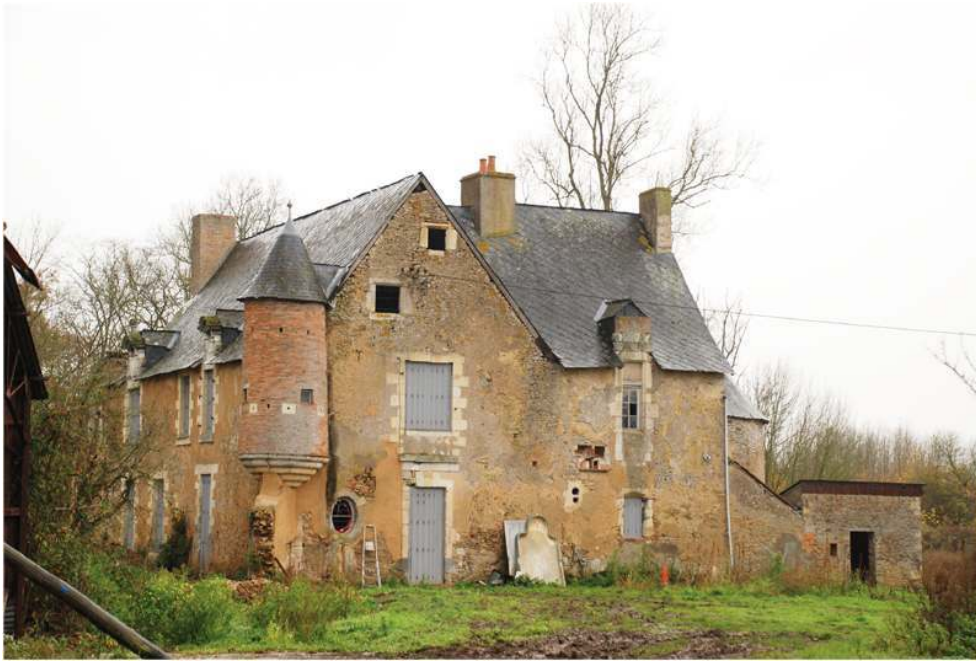
Fig. 3 – Vue du manoir depuis le nord
