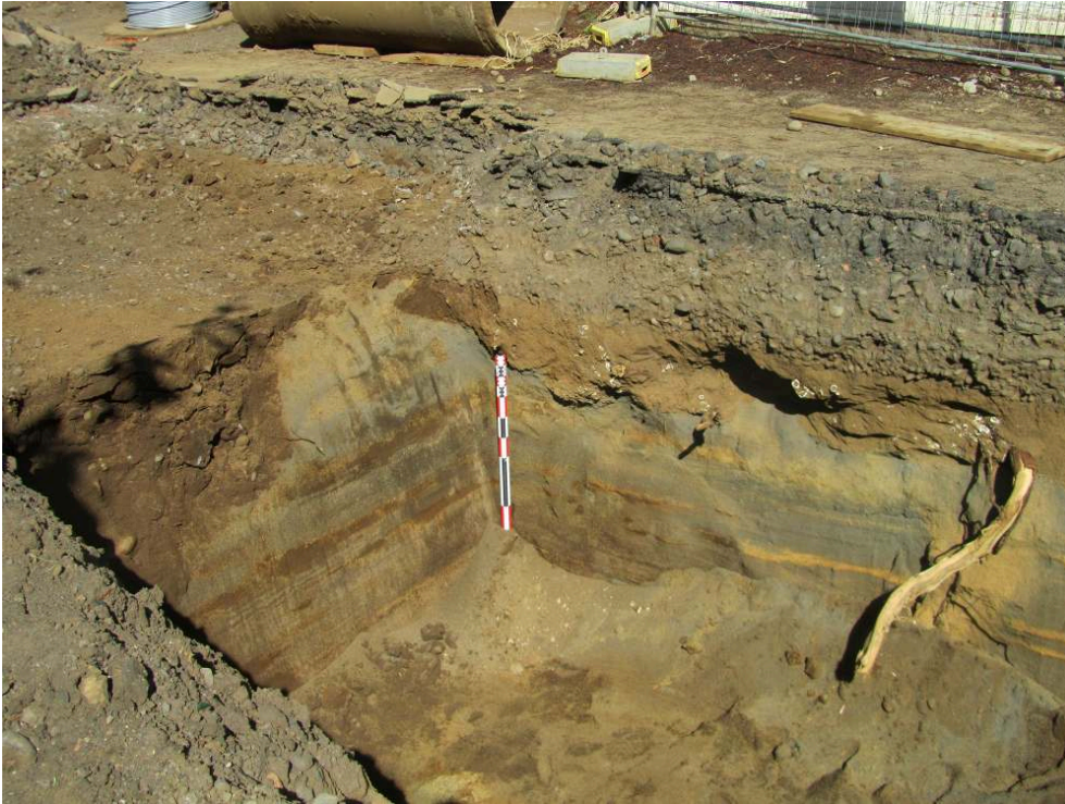
Fig. 1 – Vue de la tranchée de pose de la canalisation sous le chemin Marancourt
