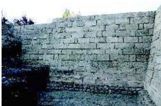
Fig. n°2 : Vue générale, vers le sud, du flanc nord du bastion Dauphin
