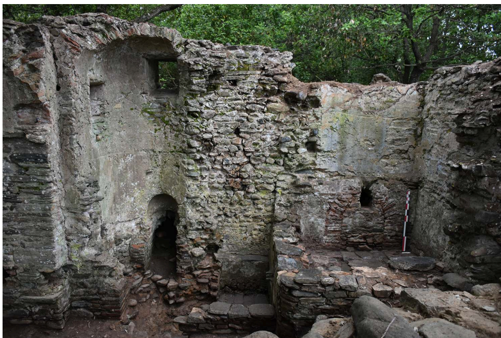
Fig. 1 – Vue de la partie occidentale ( caldarium des thermes)
