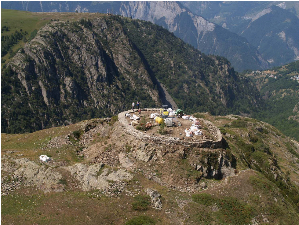
Fig. 1 – Restauration partielle du mur d'enceinte du shell-keep de Brandes
