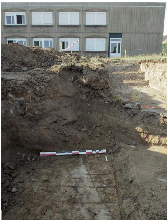
Fig. 3 – Le fait F1 dans la tranchée 3
