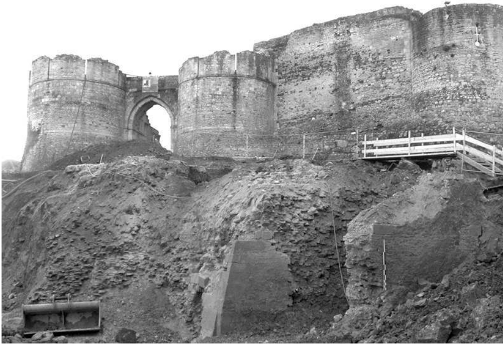
Fig. n°3 : Escarpe et ouvrage avancé au devant de la porte Saint-Nicolas
