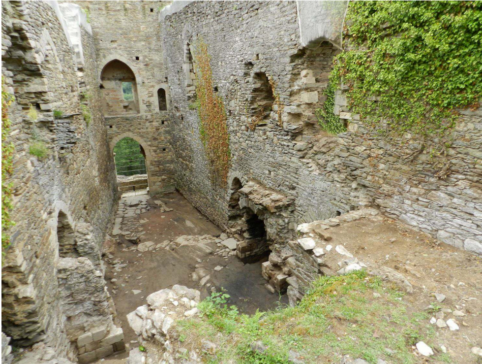
Fig. 1 – Vue d'ensemble de la cour
