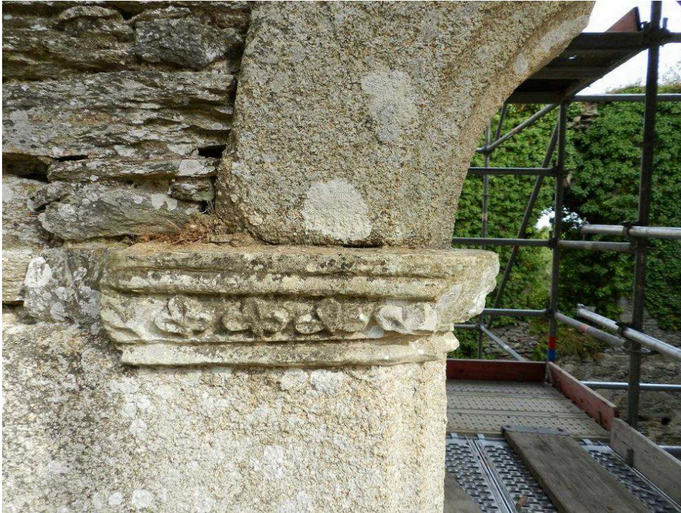
Fig. 2 – Détail de l'imposte de la baie ternée du logis est
