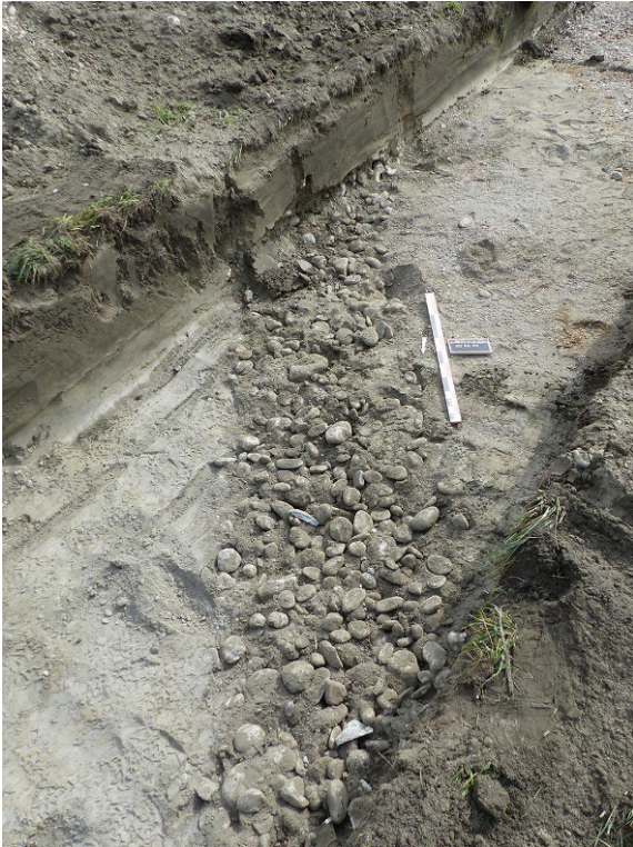
Fig. 4 – Vue générale de l'« épi » (?) de la digue de Conflans (xviii e s.)
