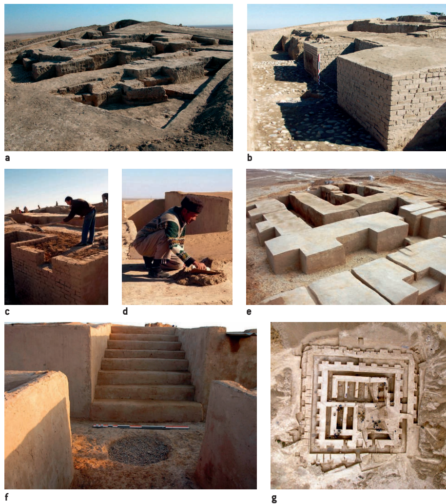
Figure 4 – Conservation-restoration de la citadelle de l'âge du fer en brique crue d'Ulug dépé ; a. État des structures architecturales post fouilles ; b. Comblement des lacunes en plan avec de nouvelles briques en terre crue ; c. Correction du pendage des murs dans leur épaisseur et aménagement de gouttières ; d. Pose d'enduit sur les structures architecturales ; e. Angle sud-ouest de la citadelle après restauration ; f. Creusement de puisard ; g. Vue aérienne de la citadelle en cours de fouilles et restauration à la fin de la campagne 2011 [© MAFTur].
