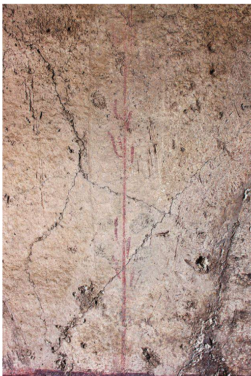
Fig. 7. Caupona della via di Mercurio (VI 10, 1), paroi sud de la pièce d, empreinte d'une règle pour le positionnement de la tige végétale.
