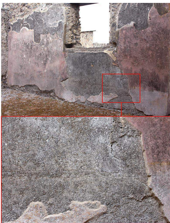
Fig. 9. Casa (VI 13, 13), paroi est du triclinium d, tracés incisés dans la couche de mortier intermédiaire.
