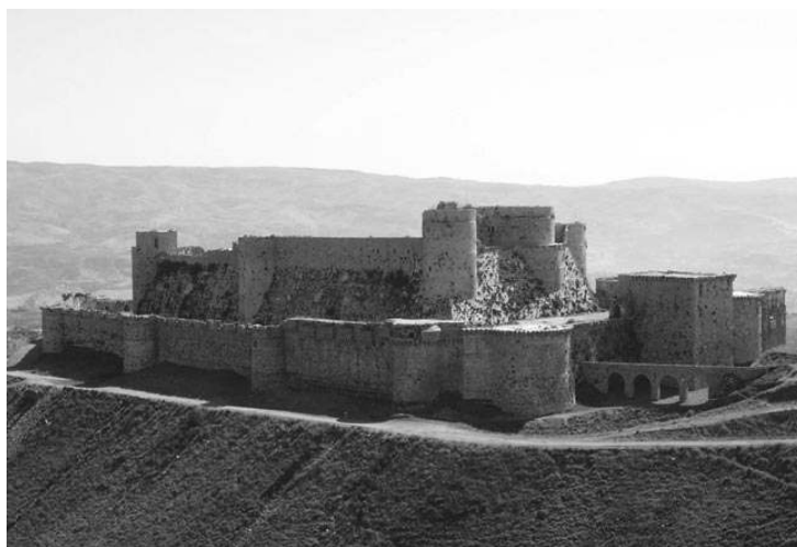
Fig. 9 : Krak des Chevaliers. Vue générale depuis le sud-ouest (à droite au premier plan, front sud avec les tours monumentales)
