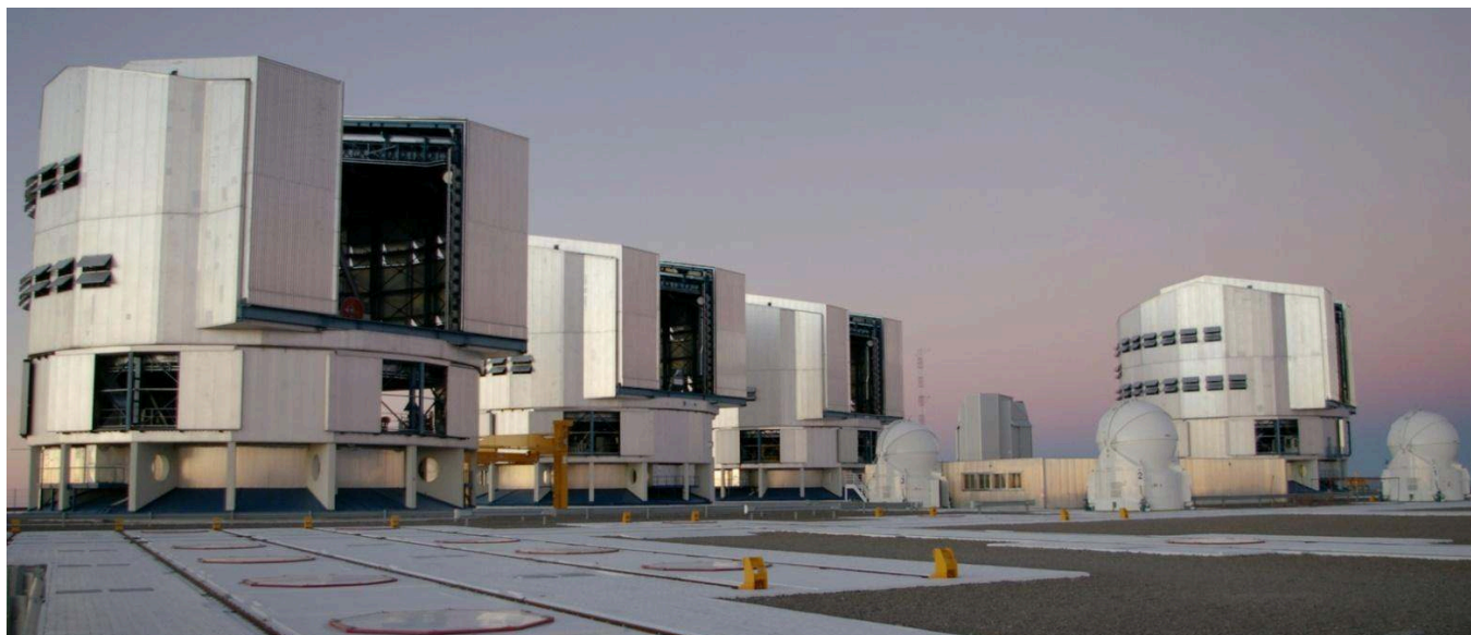
Figure 6 : Observatoire ESO, désert d'Atacama, 2635 m, Chili (depuis 2000). Plateforme VLT, avec UT1 (Unit Telescop 1) à UT4 – diamètre 8m chacun ; trois des quatre télescopes auxiliaires AT- diamètre 1,8m chacun ; entre UT3 et UT4, au fond, le télescope VST.
