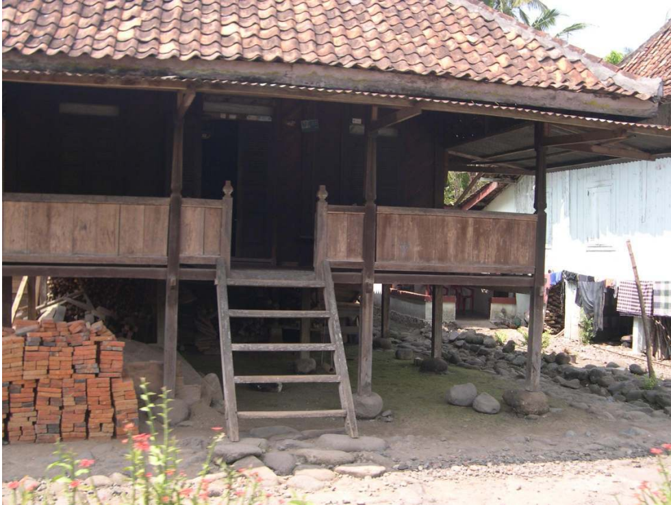
Figure 1. Maison sur pilotis au Lampung Sud
