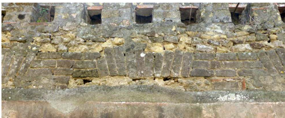
Fig. 7 – Portique 63, détail mur sud, parement nord.
