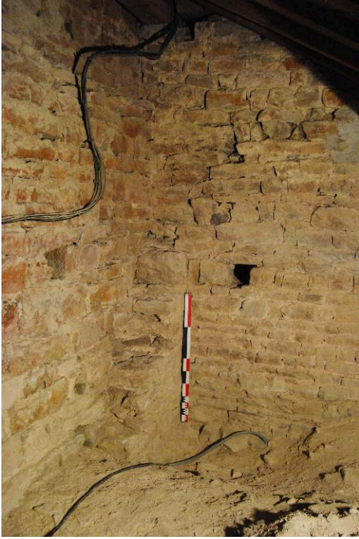
Fig. 1 – Baume-les-Messieurs, combles du bas-côté sud, détail de la maçonnerie de la première phase de la nef (cl. M.-L. Bassi)
