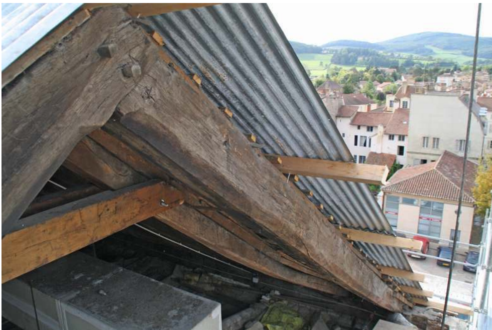
Fig. 8 – Charpente, couple de chevrons nord avec assemblage à mi-bois en tête et arrêtes abattues formant chanfreins et congés (cl. S. Aumard).
