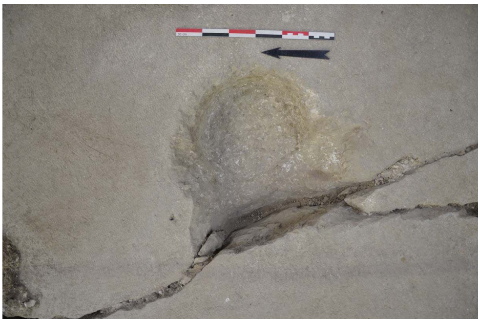
Trou ménagé in situ dans la dalle de la travée de chœur afin d'accueillir un support de table d'autel (?). Cl. équipe de fouille
