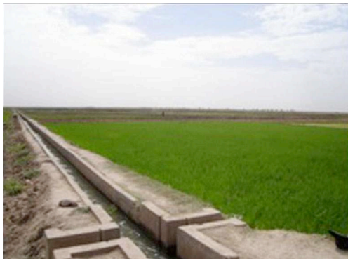
Photo 1 – Canal cimenté, à ciel ouvert, amenant l'eau dans les rizières
