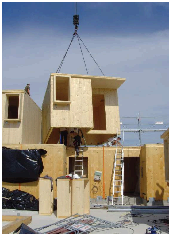
Figure 2 : le Campus universitaire des Comtes de Champagne, à Troyes. Montage des modules des chambres réalisés en CLT
