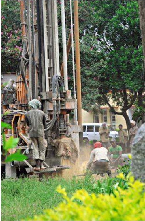
Figure 9. Illustration d'un article du 21/07/12 légendée : « Les héros de l'eau : des ouvriers en train de creuser un forage »
