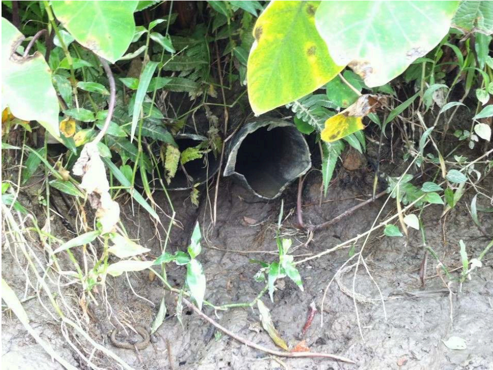
Figure 7. Photographie d'une prise directe en plastique dérivant l'eau du canal tertiaire directement dans les champs
