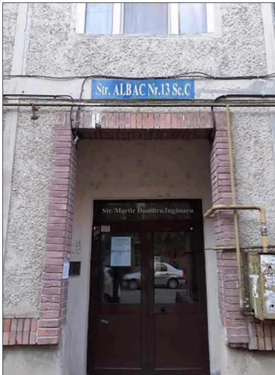
Illustration 6 - Entrée d'un immeuble situé Strada Martir Dumitru Juganaru
