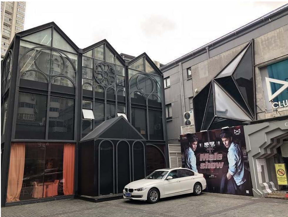
Photo n° 1. Exemple de réhabilitation d'un ancien complexe usinier à Shanghai
