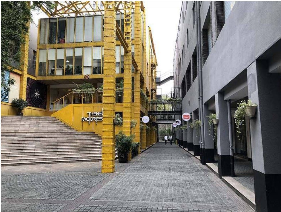
Photo n°2. Exemple de réhabilitation d'un ancien complexe usinier à Shanghai
