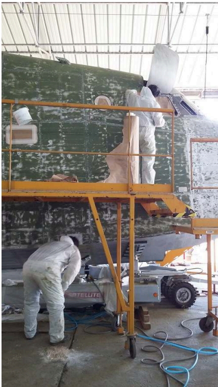
Fig.5. Opérations de préparation à la mise en peinture
