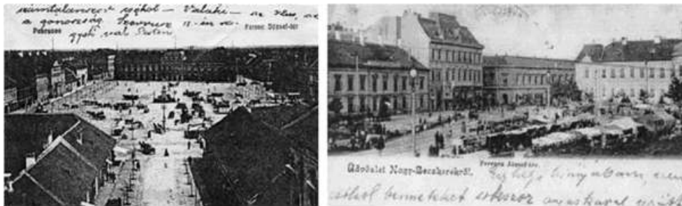
Fig. 4 : La place centrale de la ville de Zrenjanin 1918 et la place centrale de la ville de Pančevo 1900
