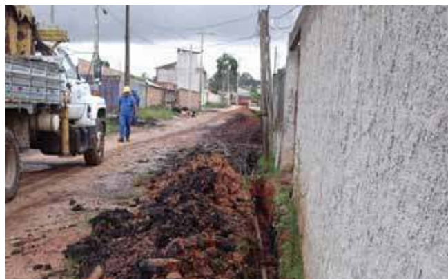
Instalação regular do sistema de água e esgoto.
