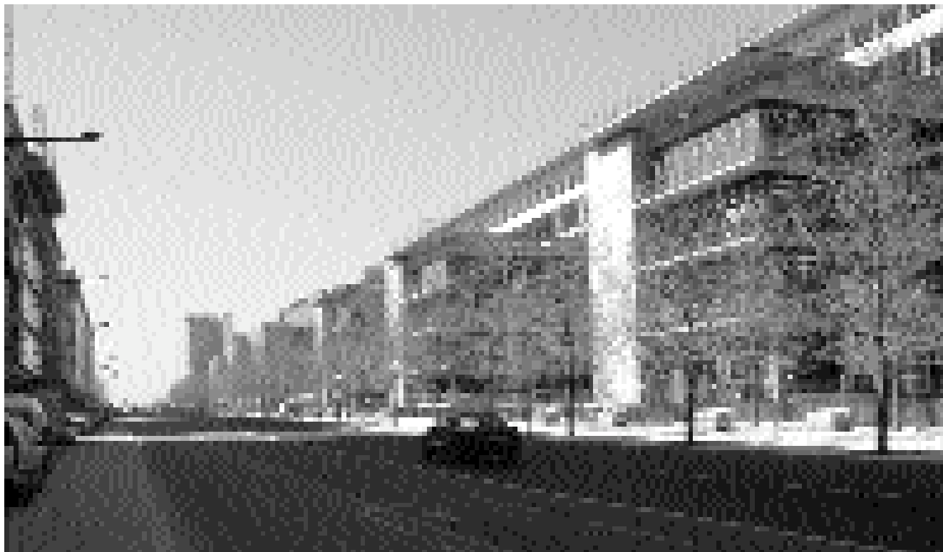
Photo 1 : Immeubles Innovatis 1 et 2 (cliché J.M., avril 2003)
