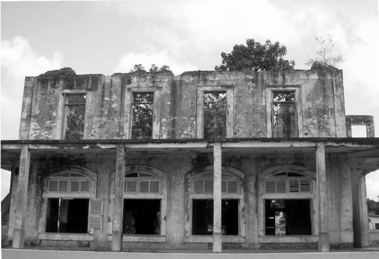
Fig. 3 Ruines d'une maison au style architectural dit « afro-brésilien », Ouidah, 2005. Photo G. Ciarcia.
