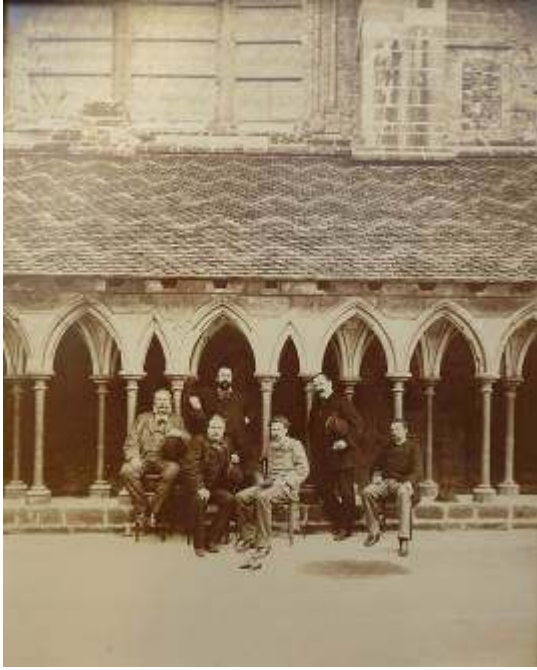
Louis Émile Durandelle, Équipe de restauration du Mont-Saint-Michel dans le cloître (avec Édouard Corroyer), s. d., tirage sur papier albuminé, Bibliothèque nationale de France, Eo98 fol (1 e partie).
