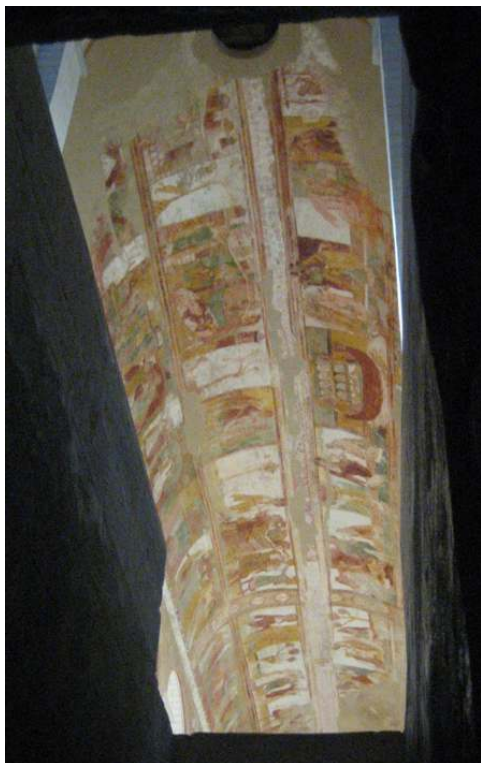
Abbaye de Saint-Savin-sur-Gartempe (Vienne). La voûte de la nef depuis la crypte. Phot. Crémier, Jean-Pierre. © CRMH Poitou-Charentes.
