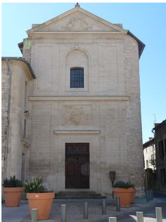
Façade de la chapelle des religieuses de Saint-Joseph, hôpital Sainte-Marthe, Avignon. Phot. Gaillard, Béatrice. © Béatrice Gaillard.
