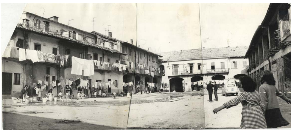
"Cascina Migassa", Cinisello Balsamo, 1964. Auteur non identifié. Milan, Archives Fondazione Isec, Fondo Unità.
