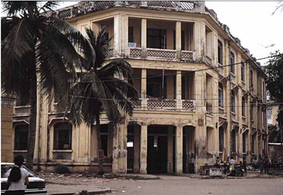
Phnom-Penh, compartiments (immeubles) près de la place de la Poste Phot. Inv. Monique Chatenet © Inventaire général, ADAGP, 1995
