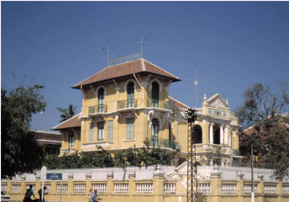
Phnom-Penh, bâtiment de l'époque du protectorat français (1863-1953), vers 1920
