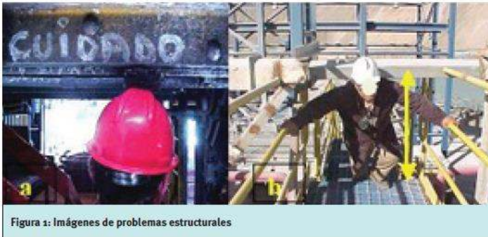
Figura 1 (a / b) : Imágenes de problemas estructurales
