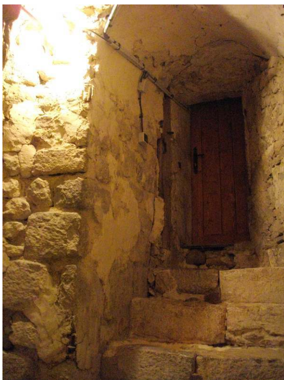
Escalier du clocher, couloir menant au deuxième niveau. Cl. É. Baillieul.
