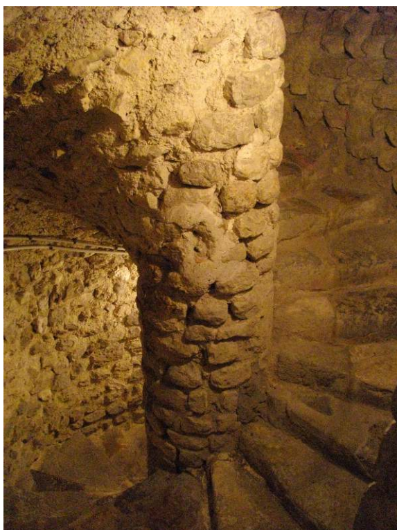
Partie inférieure de l'escalier menant au clocher. Cl. É. Baillieul.
