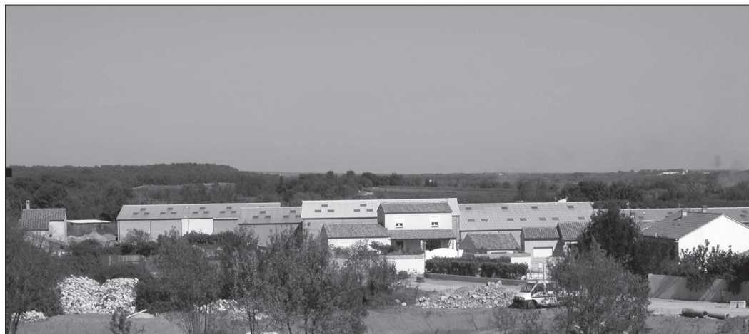
Photo 1 : Insertion du premier regroupement de hangars agricoles dans l'espace résidentiel à Saint-Géniès-des-Mourgues (B. Nougardès, 2006)
