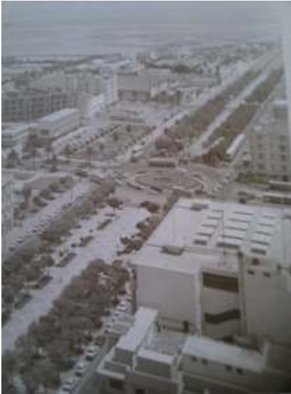
Figure 2 : Trottoirs de l'avenue principale à Manar II avec alignement de jacarandas
