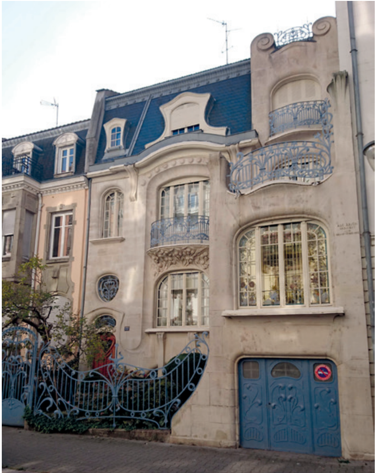
Maison personnelle de l'architecte Auguste Brion, 22, rue Sleidan, 1904-1905
