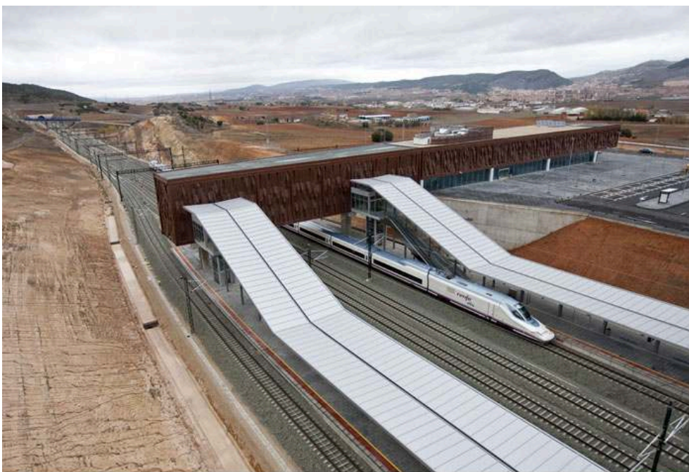
Photo 1 : Emplacement de la gare TGV de Cuenca à 5 km de la ville
