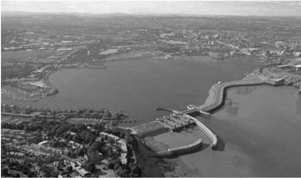
Figura 4: Barragem da Baía de Cardiff ( in Cardiff Harbour Authority )
