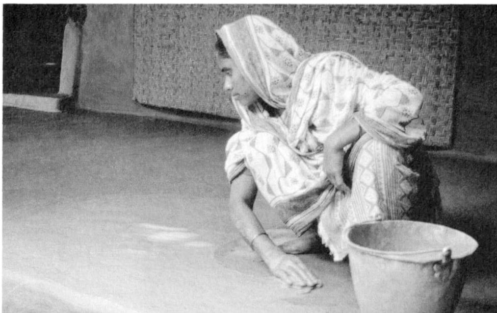
Photo 6. L'épouse applique un enduit de terre et de bouse de vache sur le sol de la terrasse
