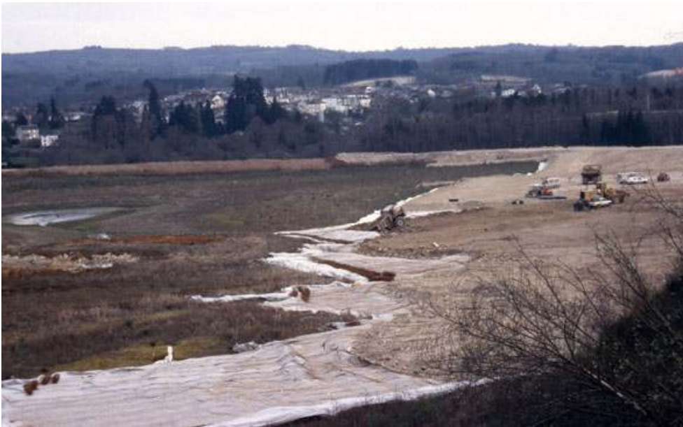
Techniques de recouvrement des boues radioactives : bâches plastifiées, quadrillage métallique, stériles miniers concassés, mai 1994
